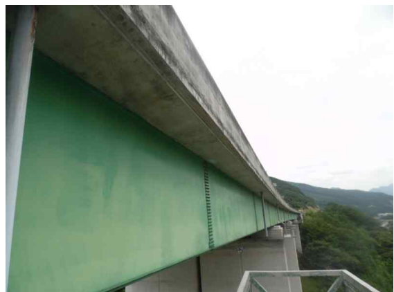
Steel Box Girder 외부 전경
