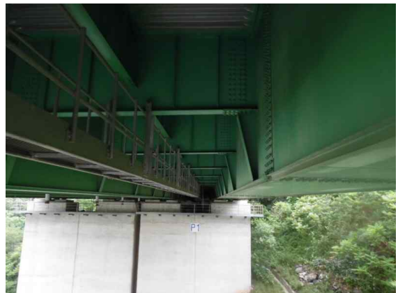
Steel Box Girder 외부 전경
